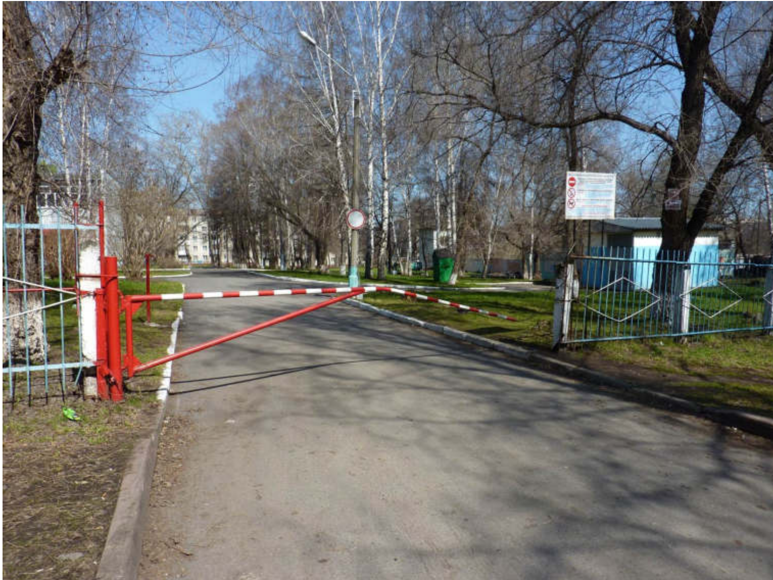
Рис. № 1 Центральный вход – въезд на территорию
