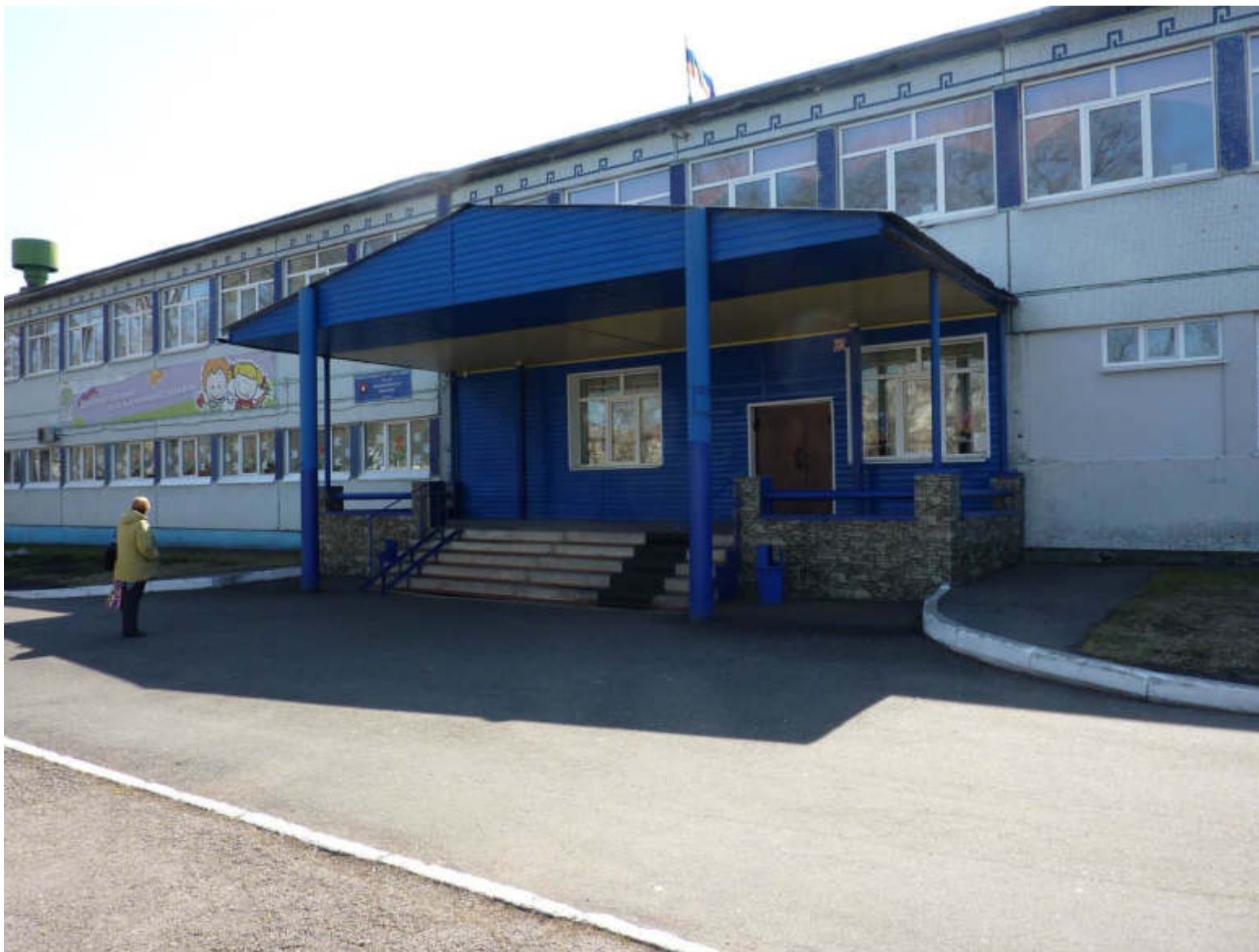
Рис. № 22 Лестница наружная
