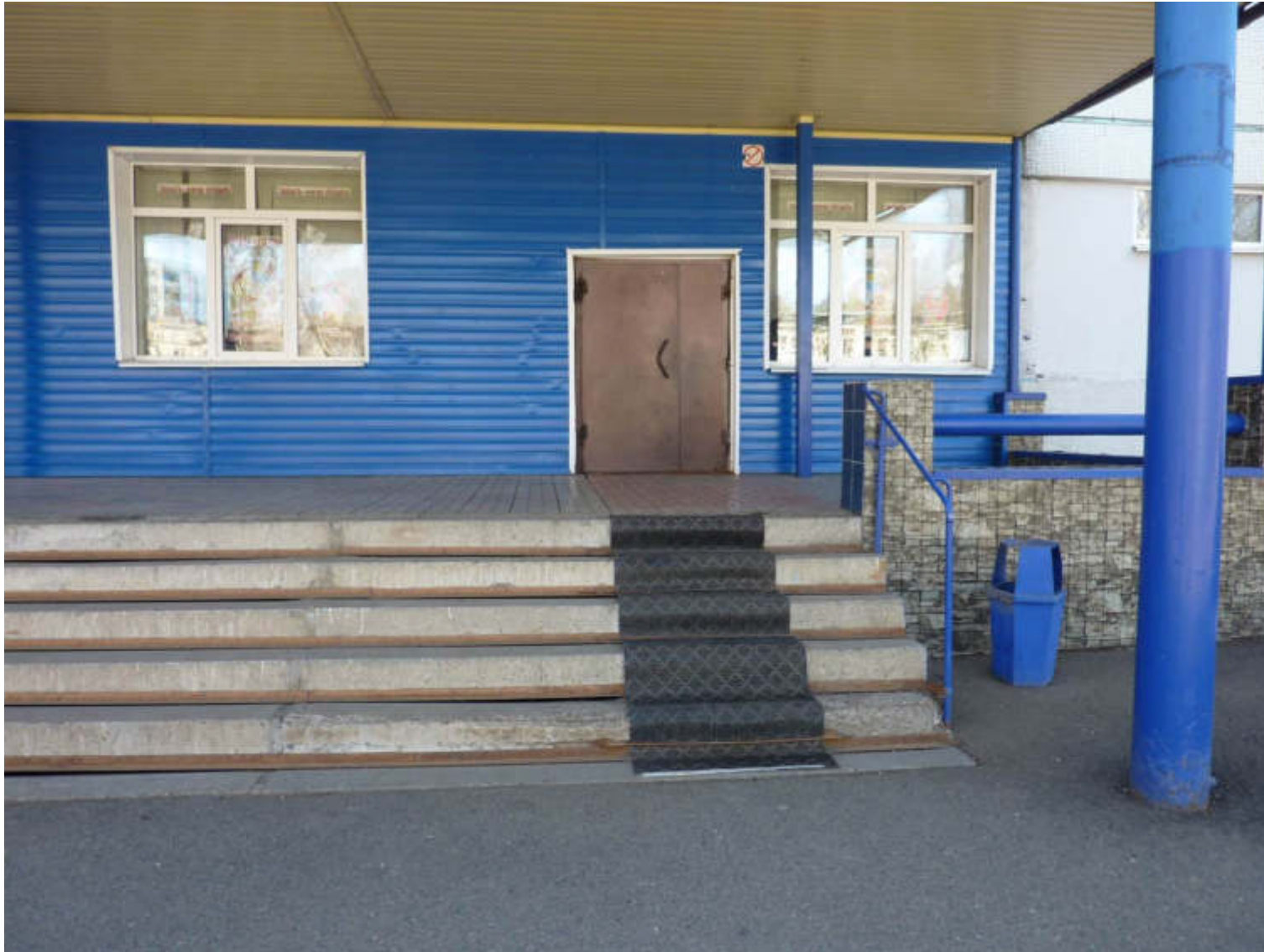
Рис. № 24 Лестница наружная
